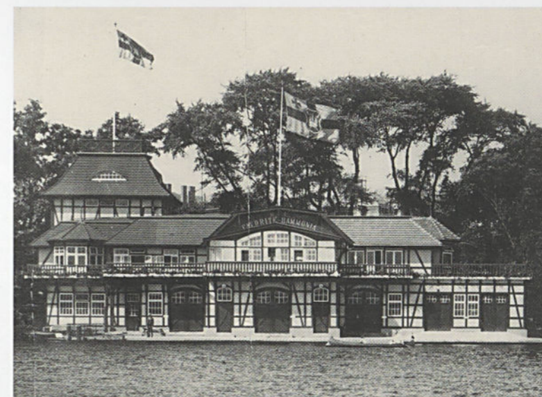
Bootshauserweiterung 1914 mit großem Bootsschuppen, in Hamburg noch unbekanntem Ruderbecken, größeren Ankleide- und Waschräumen sowie einer Festsaalverdopplung
